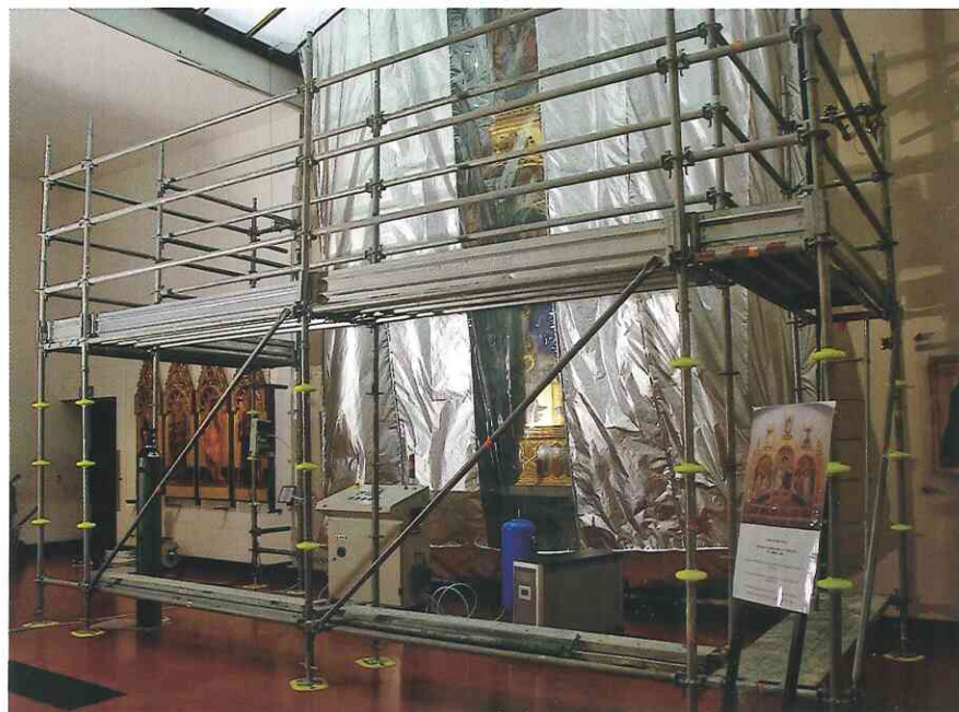
Il cantiere per la disinfestazione del polittico di Lorenzo Monaco.
